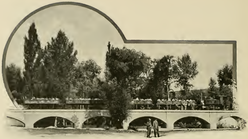
Abb. 135. Viaduct aus Stampfbeton bei Pohrlitz. [Kaiser Ferdinands-Nordbahn.]
